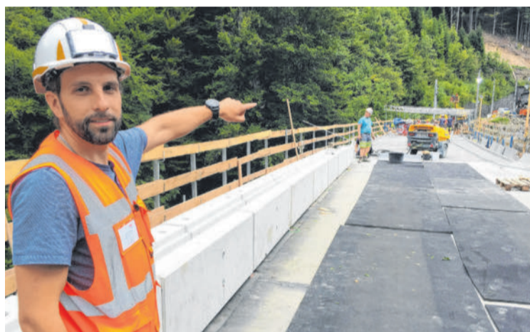
Bauleiter Andreas Schimpfössl zeigt sich über den Bauverlauf äußerst zufrieden: „Wir liegen sehr gut im Zeitplan.“
