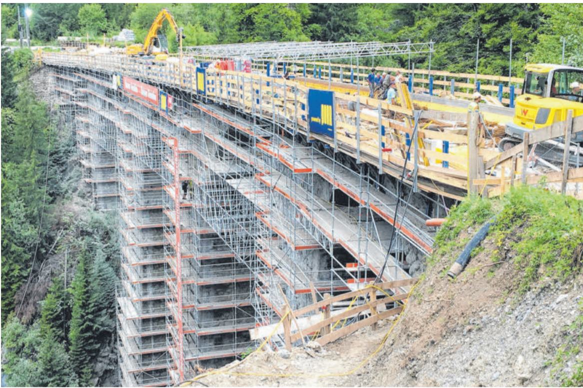
Bei der Sanierung des Schmid-Tobel-Viadukts in Dalaas sind zu Spitzenzeiten bis zu 35 Arbeiter parallel im Einsatz.
