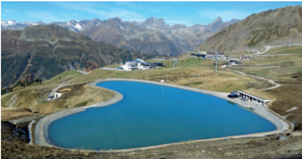
Silvretta Arena Ischgl-Samnaun: Mit der Errichtung des Speichersees Viderböden und der neuen Beschneigungsanlage erhielt das Ischgl Skigebiet im Vorjahr ein neues, zentrales „Verteilerherz“ für die technische Beschneigung. Damit wurde der bisherige Dreh- und Angelpunkt beim Speichersee Idalp in dieser Funktion abgelöst.
